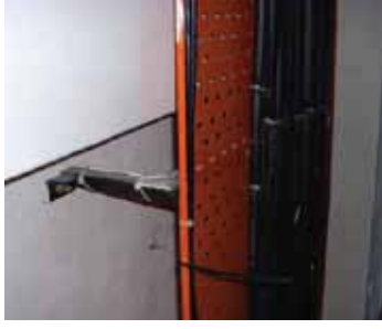
الشكل ٥-١٤: تركيب الأنبوب العمودي على حامل الكابلات
